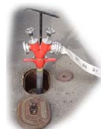
Idrante sottosuolo
